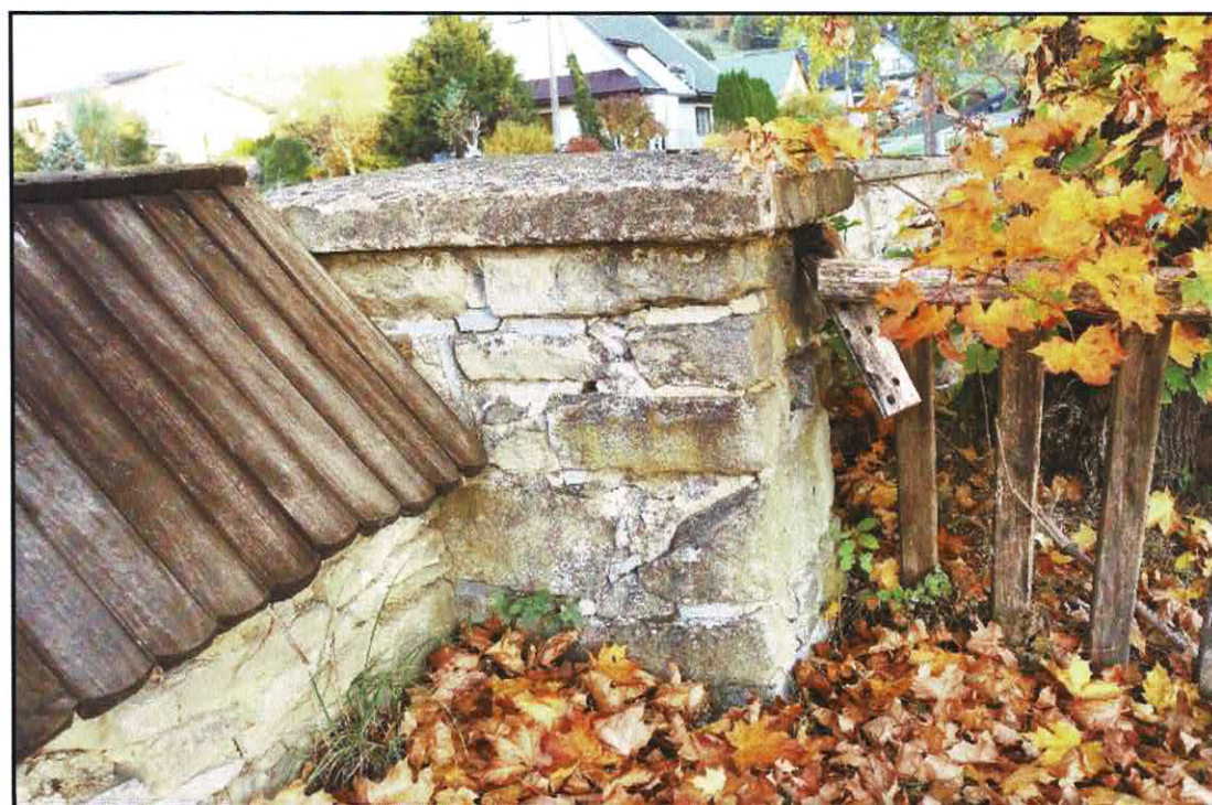
FOT. 18. CMENTARZ Z I WOJNY ŚWIATOWEJ NR 71 W ŁOSIU. Słup ogrodzenia z kamienia, stan przed konserwacją.
