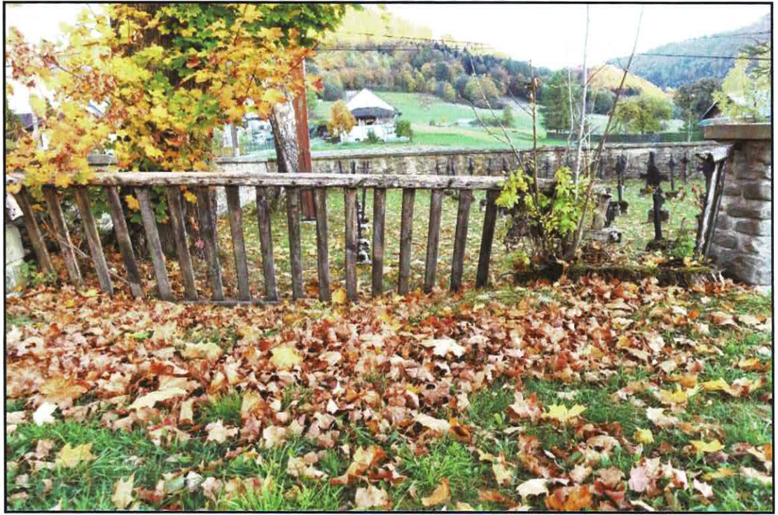
FOT. 25. CMENTARZ Z I WOJNY ŚWIATOWEJ NR 71 W ŁOSIU. Zniszczony odcinek drewnianego parkanu od str. zach., stan przed konserwacją. Październik 2022 r.
