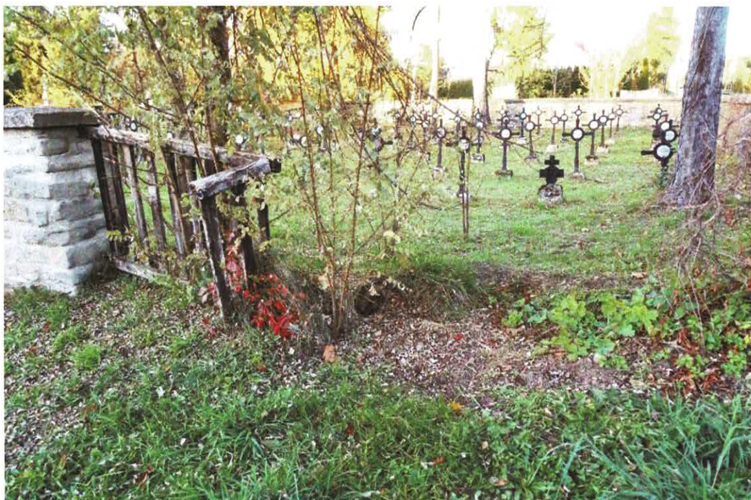
FOT. 19. CMENTARZ Z I WOJNY ŚWIATOWEJ NR 71 W ŁOSIU. Zniszczony odcinek drewnianego parkanu od str. płd.- zach., stan przed konserwacją. Październik 2022 r.
