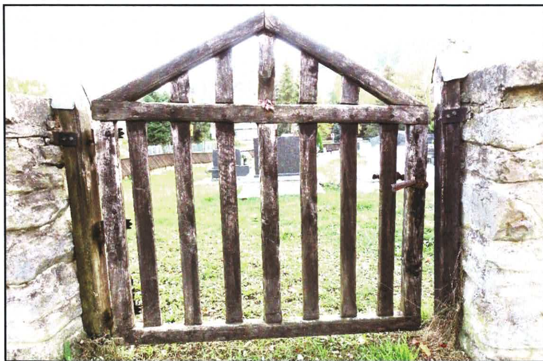
FOT. 20. CMENTARZ Z I WOJNY ŚWIATOWEJ NR 71 W ŁOSIU. Zniszczona furтка od str. płd.- zach., stan przed konserwacją. Październik 2022 r.
