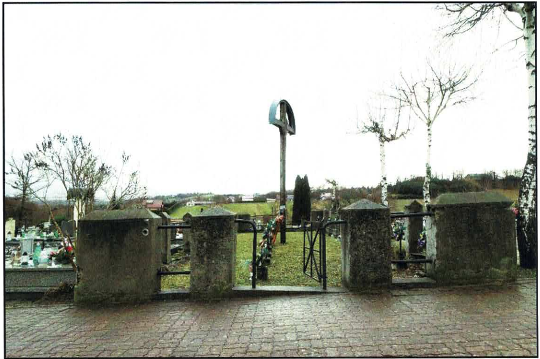
Fot. 3. CMENTARZ Z I WOJNY ŚWIATOWEJ NR 72 W ROPIE Widok cmentarza wojennego od str. płd., stan przed konserwacją.
